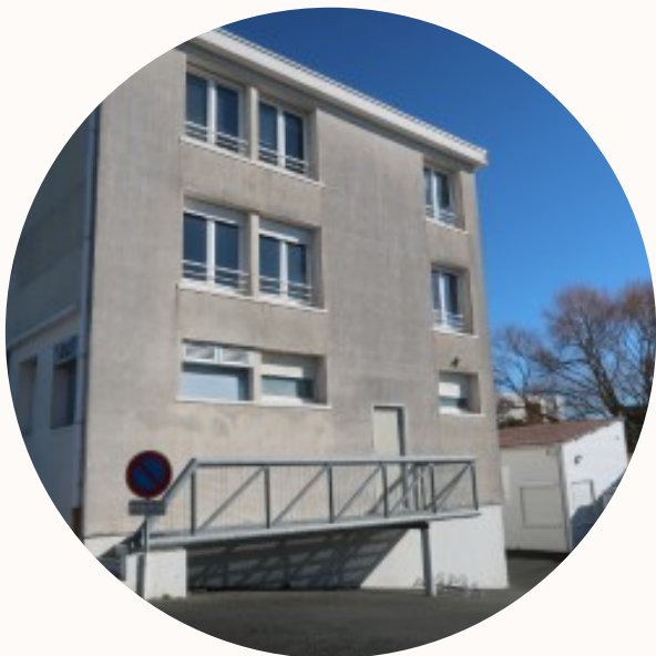
Rue de l'Électricité (locaux mis à disposition par la CARA)
